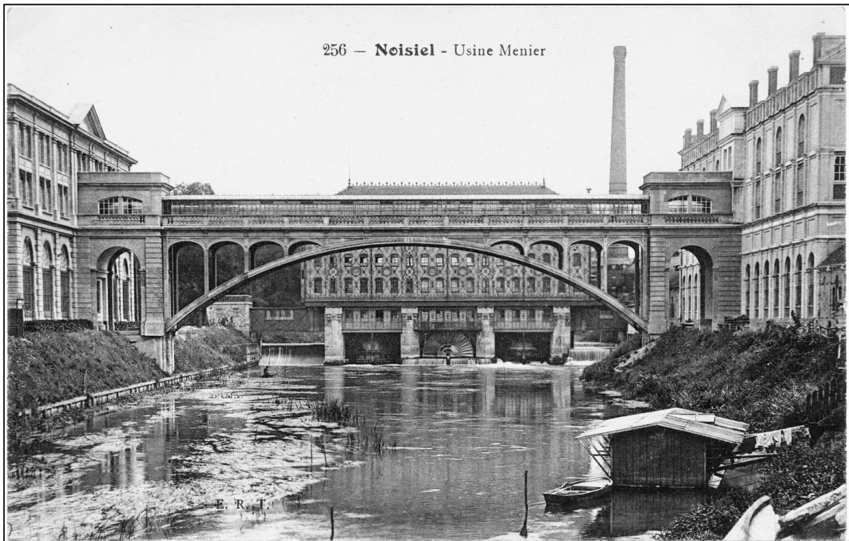
Au fond, le moulin Saulnier (usine Menier), sur le bras sud de la Marne, vue de l'aval en période d'étiage. On voit bien les 3 turbines Girard, 2 à axe vertical et à siphon (1871 et 1875) de part et d'autre de l'ancienne roue à hélice à axe horizontal (1854), et les 2 petits déversoirs (C.P.A postérieure à 1909, collection B. Garnier, Galerie de l'Epistolaire)
