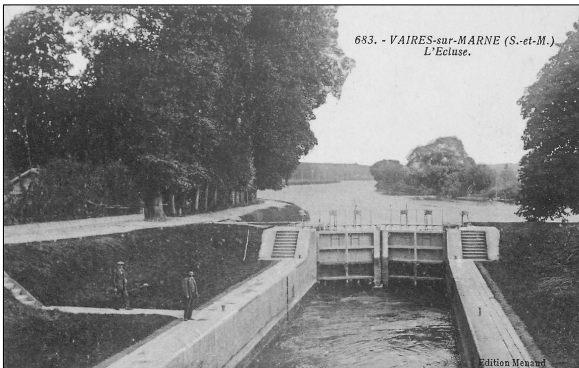
L'écluse de Vaires, porte amont, la Marne en arrière plan, vue du début du XXe siècle (C.P.A Collection Delcampe)
