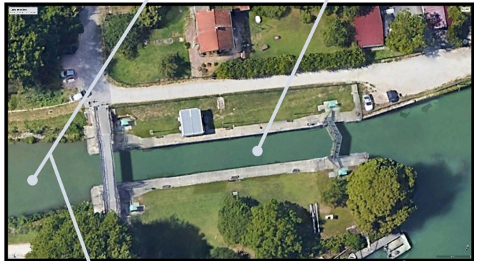
Le canal de Chelles et l'écluse de Vaires
