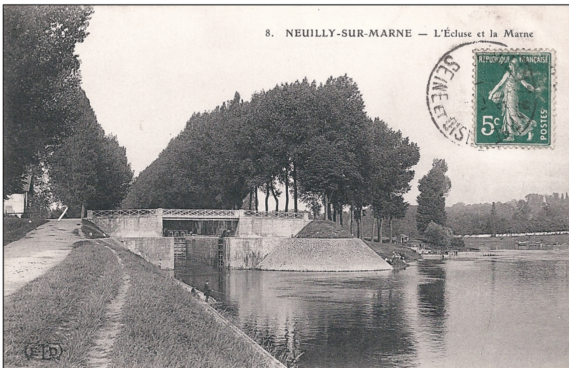
L'écluse de Neuilly, fin du canal de Chelles. La porte aval ouverte permet d'apercevoir la porte amont. A droite la Marne, dont le niveau à l'étiage peut être jusqu'à 5 mètres sous le niveau du canal (C.P.A Collection Delcampe)
