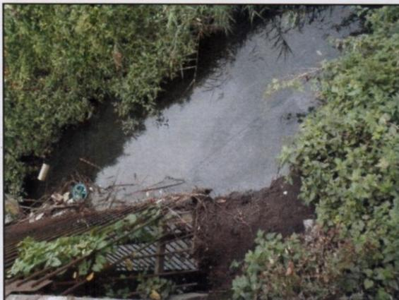
Photo 6 Dépôt de sédiments au niveau du dégrillage en T4
