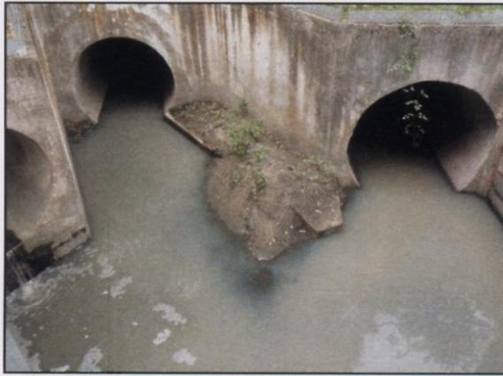
Photo 3 Dépôt de sédiments au niveau de l'arrivée des buses du T1 (eaux pluviales et ru de Chantereine)
