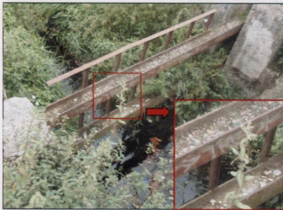
Photo 4 Mise en évidence d'un transport de graviers au cours d'épisodes pluvieux au niveau du pont du T2
