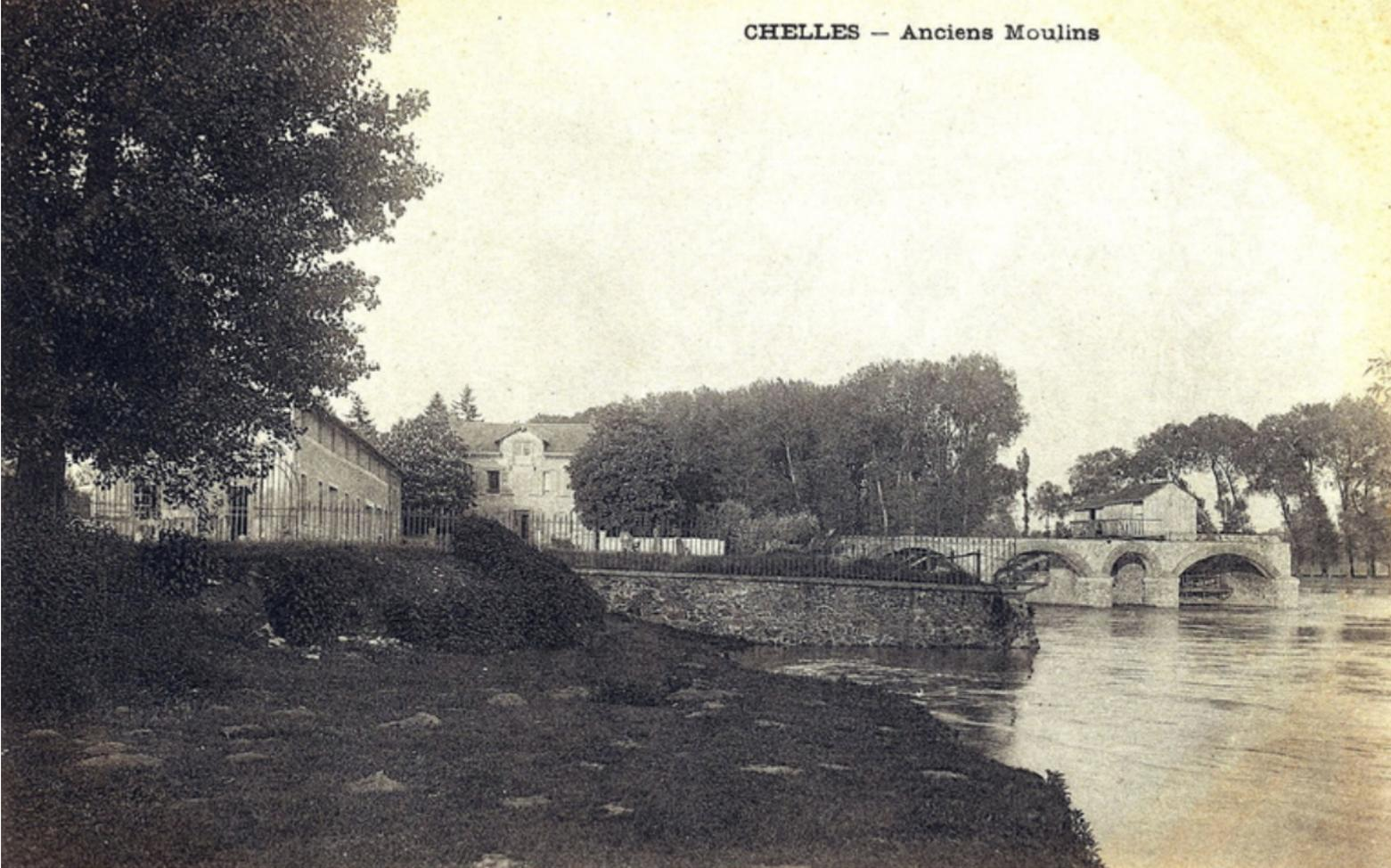
**Moulin.** Les grilles autour de la propriété témoignent d'un endroit sécurisé. Sur le quai l'ancienne usine démolie a été remplacée par une habitation, de face la maison des gérants et le moteur hydraulique sur les arches avec ses deux cabanes sur la roue...
