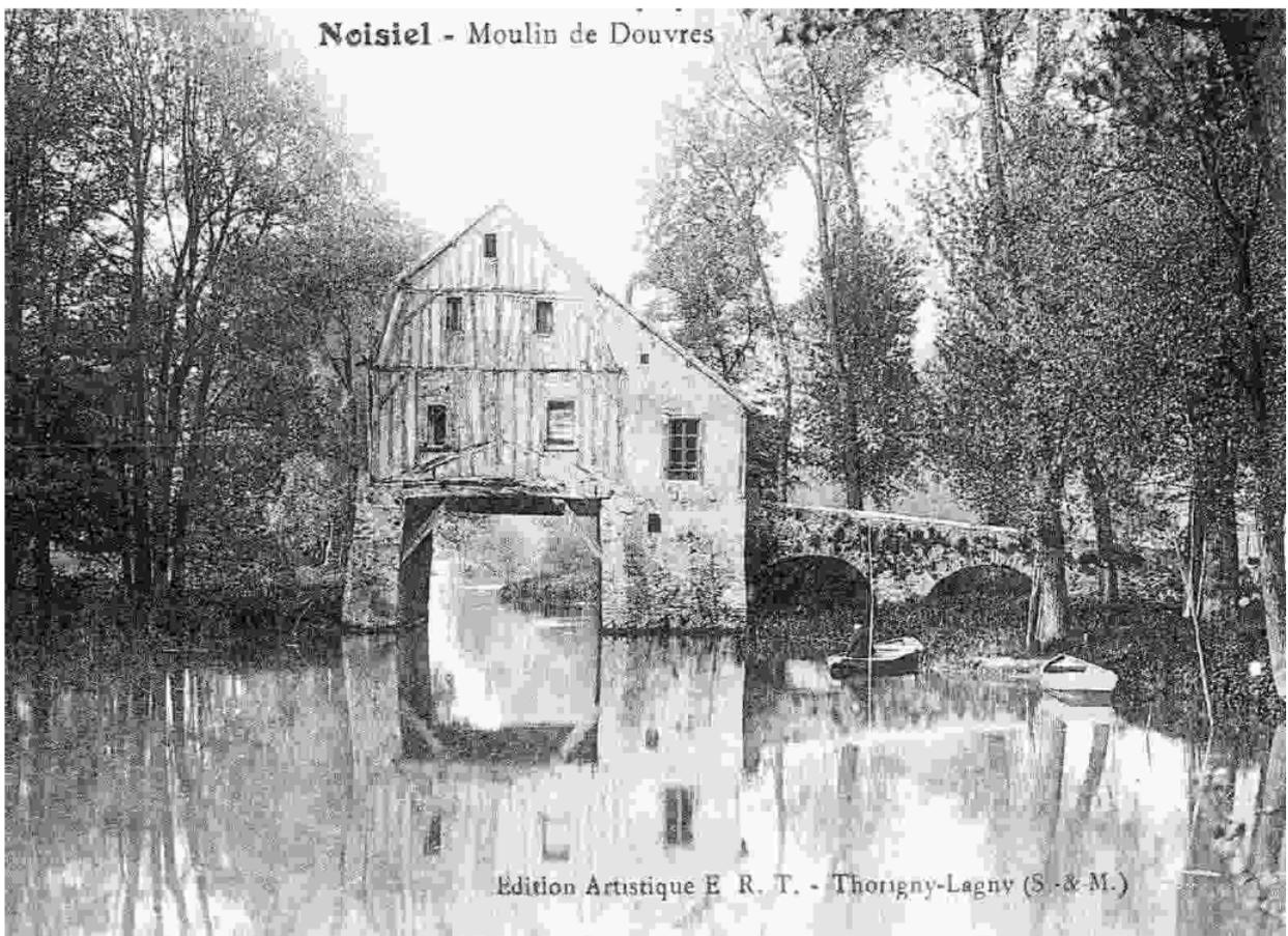
Construit sur le même modèle que le **Moulin de Torcy**: boisé dans sa partie supérieure, avec rampe d'accès et soubassement en maçonnerie...
