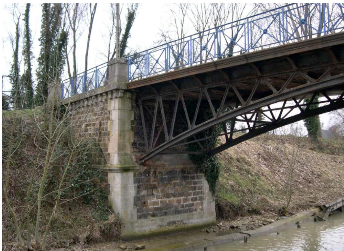
Construits en même temps que le canal en 1860, ces deux ponts métalliques sont, à Chelles, **les seuls éléments de l'architecture civile de la seconde moitié du XIXe siècle**, avec les arches du Moulin sur la Marne. Malheureusement il ne sont pas estimés à leur juste valeur, des ouvrages d'art du passé. Le tablier repose sur quatre boudins de caoutchouc permettant une remarquable élasticité.
