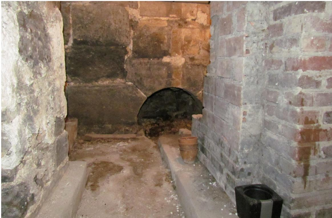
Ce que l'on découvre dans la cave: un mur ancien en pierres taillées avec une voûte. Sur le côté des murs de briques ajoutés avec le temps pour soutenir l'édifice. Et sur la gauche ce qui reste d'un four en briquettes.
