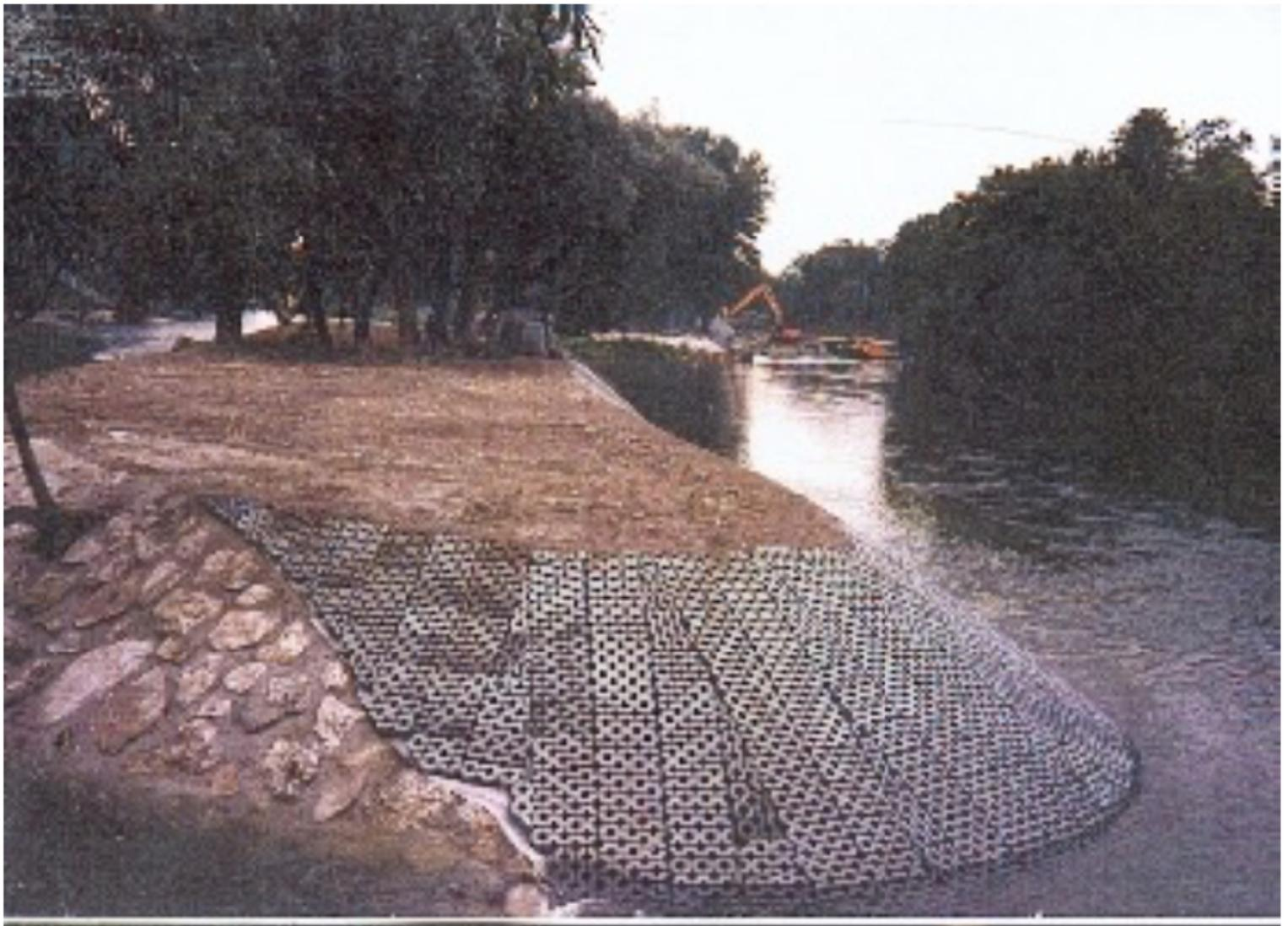
**Les dallettes béton, les palplanches métalliques et les pierres jointoyées de ciment condamnent la rivière à l'asphyxie. (photo îlots Jumeaux, 5 et 6 sur la carte, aménagés en août 1995).**
