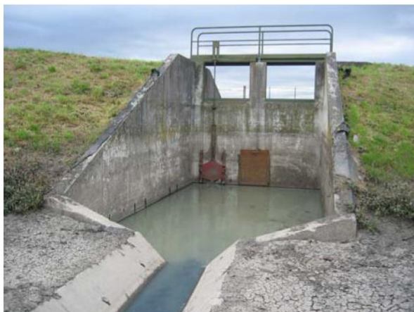
Figure 12 : Vue de l'intérieur du bassin de la chambre aval
