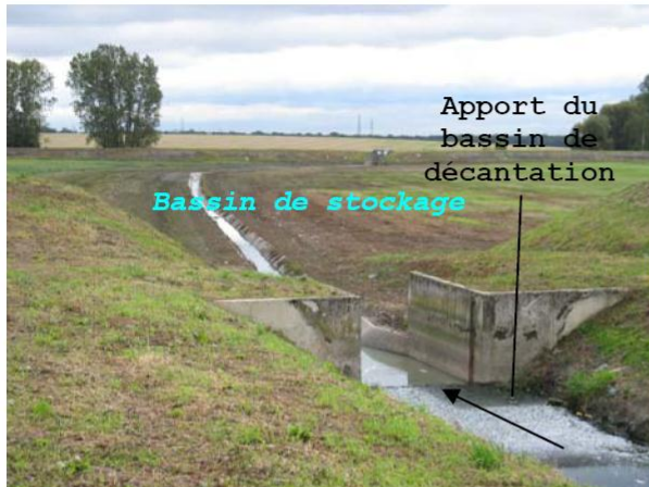
Figure 8 : Vue du bassin de rétention
