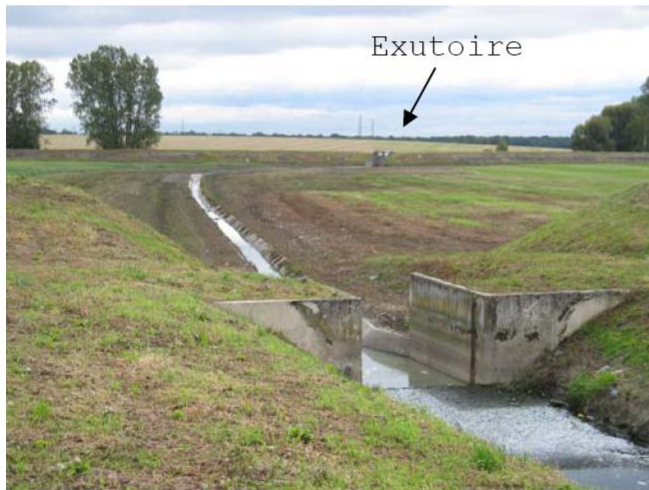
Figure 1 : Vue du bassin de stockage (au fond, l'exutoire)
