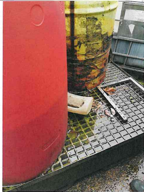
Photo 16 débordement de rétentions non abritées au 185 avenue du Général Castermant - Chelles
