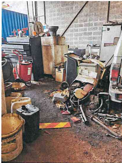
Photo 9 stockage sur sol non imperméable taches d'hydrocarbures au 185 avenue du Général Castermant - Chelles
