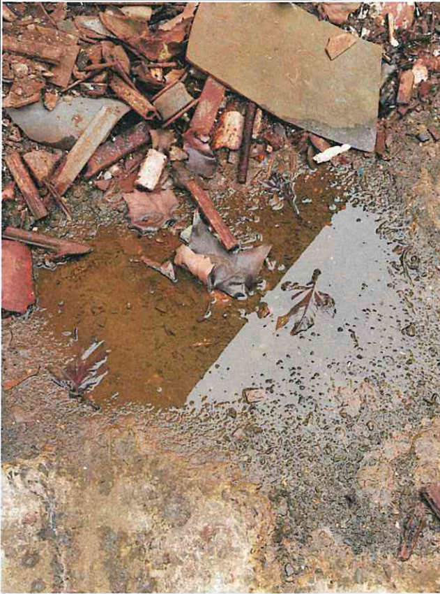
Photo 23 ruissellement des eaux pluviales sur les métaux au 185 avenue du Général Castermant - Chelles
